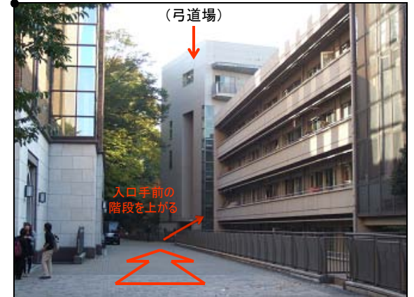
広場からみた富士見会館:奥の建物の屋上が弓道場です。 入口手前の階段を上がって3階からエレベーター利用するのが便利です。
